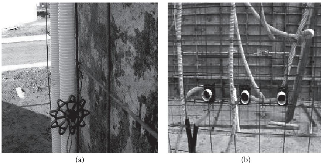
Figura 3 – Espaçadores: (a) colocação de espaçadores; (b) instalações elétricas e hidráulicas posicionadas na armadura
