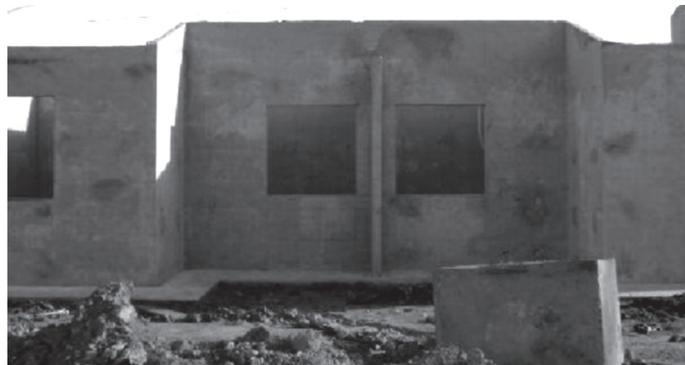
Figura 7 – Casas após a desforma
