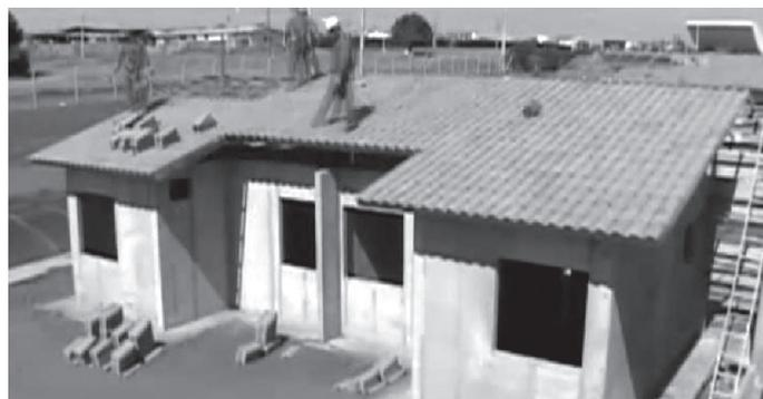
Figura 8 – Execução da cobertura em telhas cerâmica
