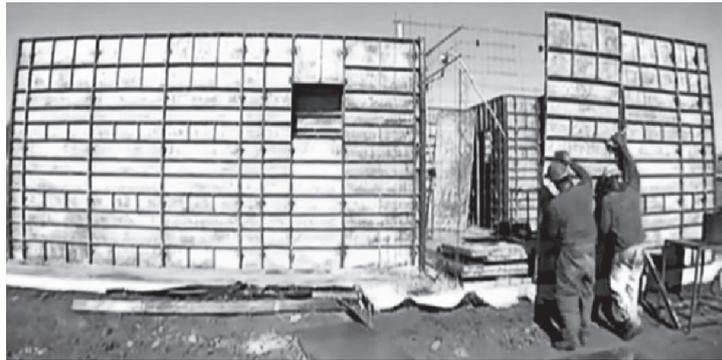
Figura 4 – Montagem dos painéis metálico
