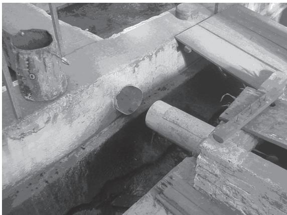
Figura 2 - Foto da tubulação lateral que liga a fossa séptica à ETE
