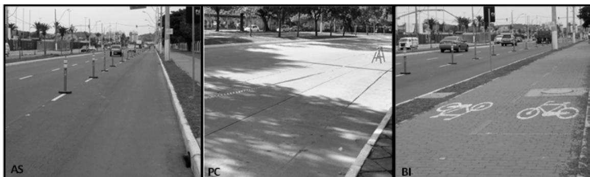
Figura 6 - Tipos de pavimentação empregados nas medições: asfalto (AS), placas moldadas "in loco" de concreto (PC) e blocos intertravados de concreto (BI)
